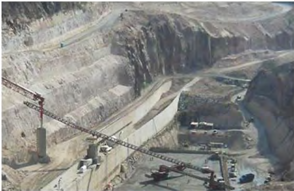
El Zapotillo, una de las represas de hormigón compactado con rodillos más grande del mundo. Para este proyecto, LafargeHolcim suministró una oferta integrada que incluye cemento especial, agregados, hormigón premezclado y hormigón compactado con rodillos, así como servicios de logística y pruebas.
